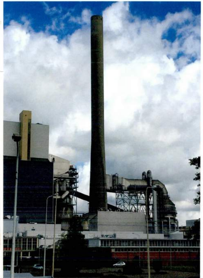
De betonnen schoorsteen van de Hemweg centrale te Amsterdam.
