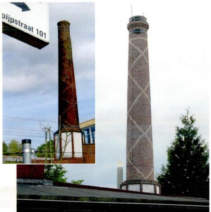
De oorspronkelijke schoorsteen links de herbouw rechts met op de achtergrond de betonnen schoorsteen van de Pegus Centrale.
