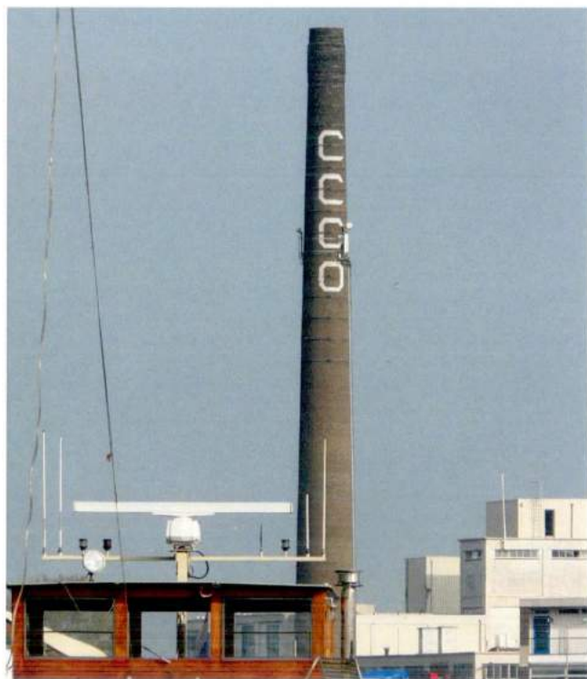
De schoorsteen van de Coöperatieve Condens fabriek Gelderland Overijssel zoals de letters aangeven
