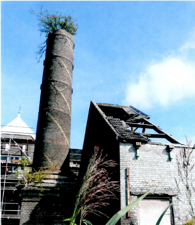
Oosthem, schoorsteen uit 1901 van de v.m. zuivelfabriek
