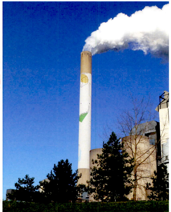
Nijmegen de betonschoorsteen met geschilderde versiering.
