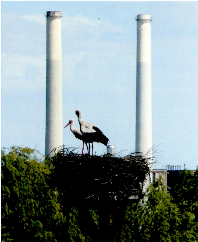
Zwolle 2013: de twee schoorstenen van de Harculo-centrale.
