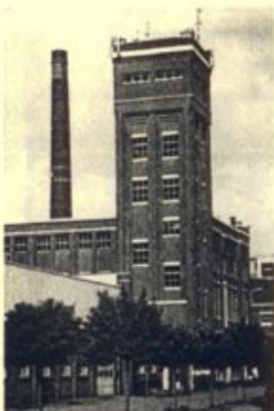
Schoorsteen Van Heek & Co, 1927 Losser, 55 meter. Bouwer Fa. Geelen
